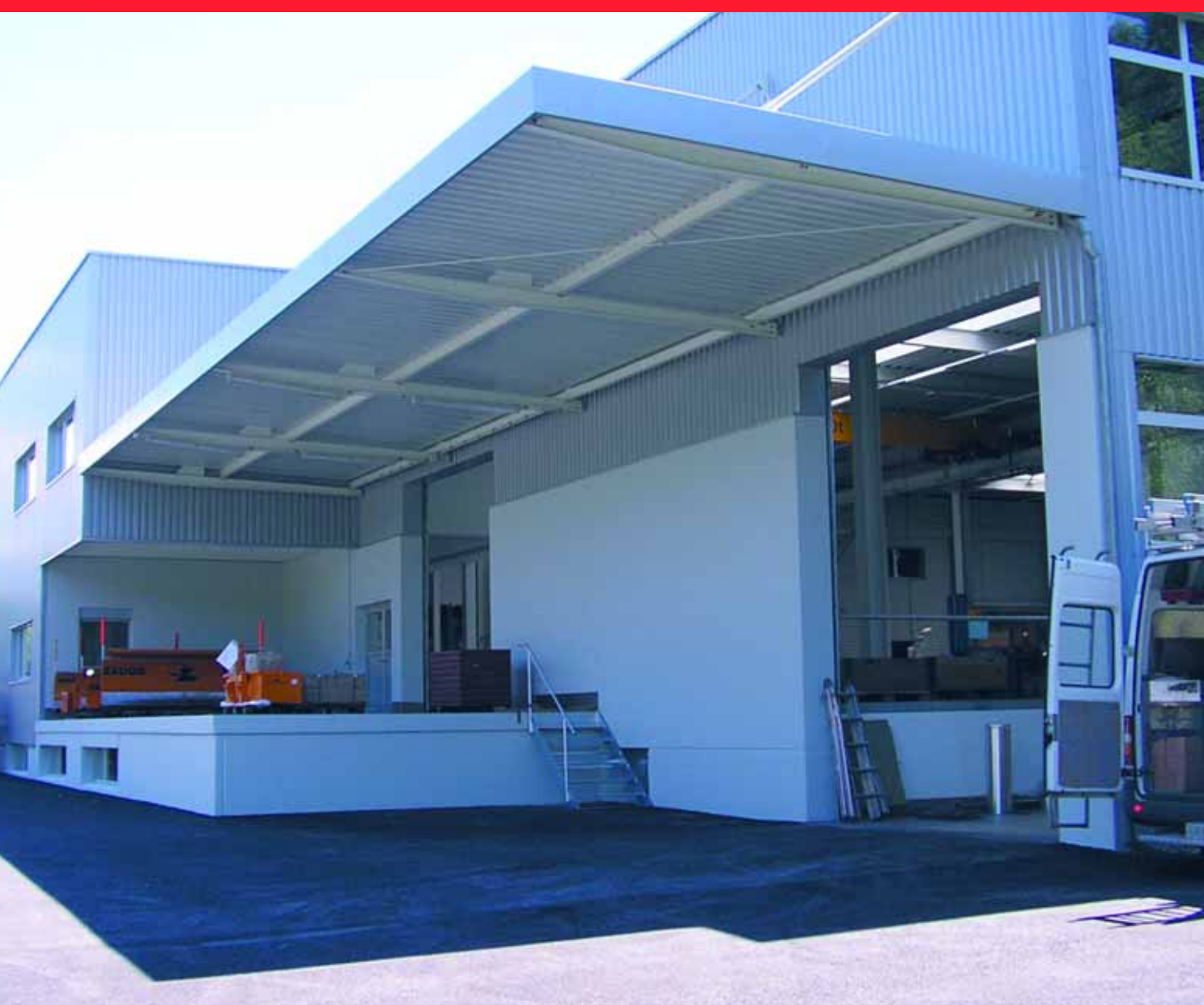
Nach zehnmonatiger Bauzeit fertiggestellt. Die neue Produktionshalle der Zaugg AG.
